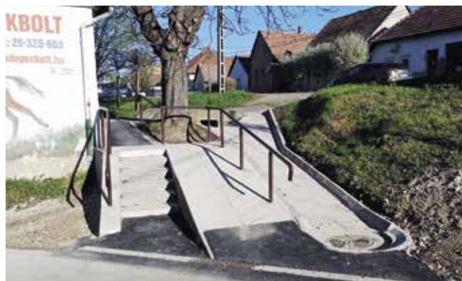
Elkészült a főtérnél a németes iskolánál és a Bodza utcánál lévő lépcsők felújítása, amelyek részben akadálymentesítve lettek és korlátot is kaptak
